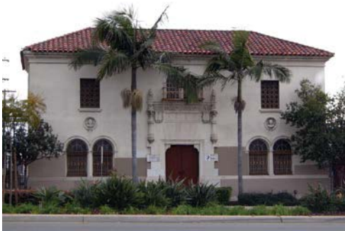
SDG&E Co., Substation F, 3169 El Cajon Boulevard.
