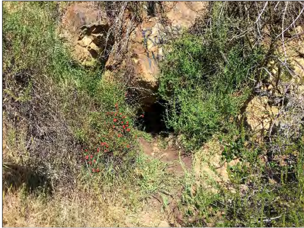
Portal of adit.
