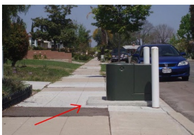
TRIP & FALL HAZARD
