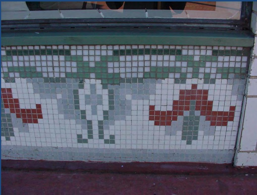
Granada Bldg tile.
