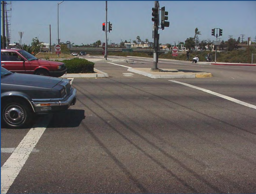
Crossing El Cajon Blvd/I-805.
