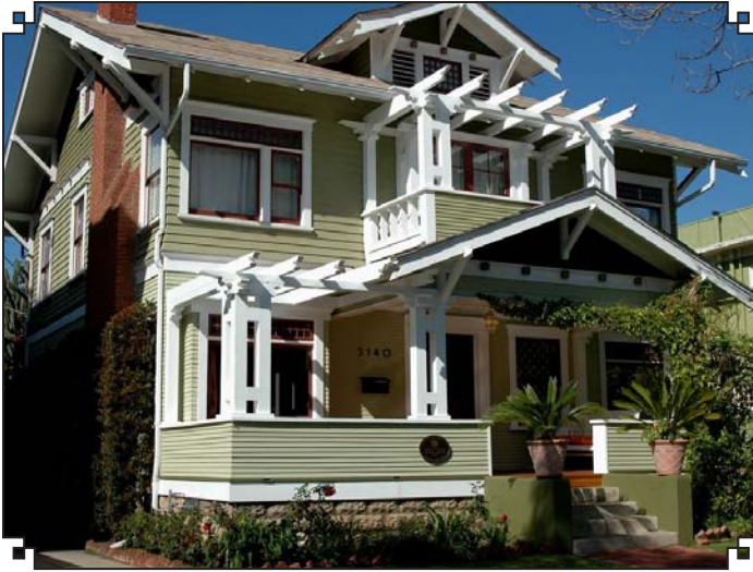
Casa de Irvin y Vitulia Randall después de la reconstrucción del balcón y la terraza.
