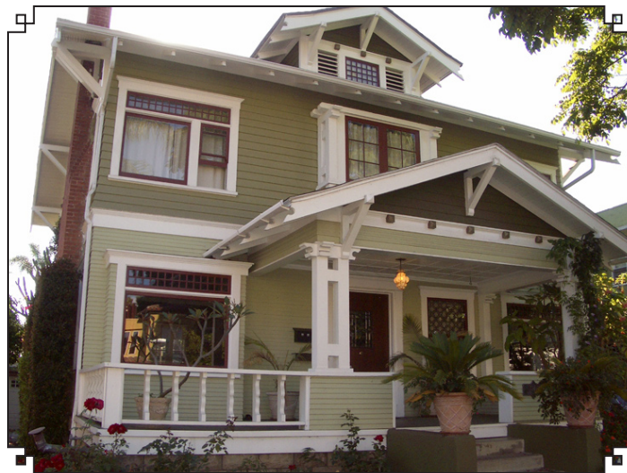
Casa de Irvin and Vitulia Randall, construida en 1910 y designada en Octubre 2006 bajo Criterio C como un buen ejemplo de arquitectura Artesana. Condiciones del Acto Mills requirieron reconstrucción de la terraza y del porche. Proyecto completo a la izquierda.
