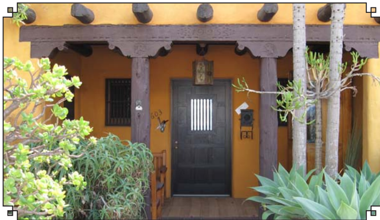
La Casa de Sarah Brock/William Templeton Johnson, construida en 1925 y designada en Noviembre de 2007 bajo Criterio C por su estilo Resurgimiento de Pueblo y bajo Criterio D por su asociación con Maestro Arquitecto William Templeton Johnson.
