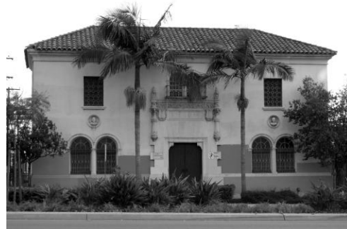
SDG&E Co., Substation F, 3169 El Cajon Boulevard.
