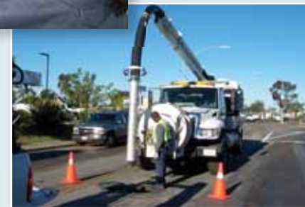
Limpieza de las líneas de alcantarillado
