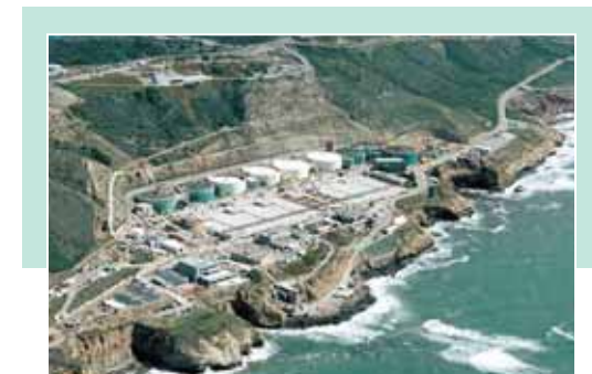
Planta de tratamiento de aguas residuales Point Loma
