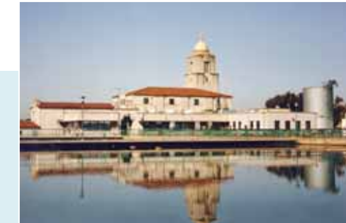
Planta de tratamiento de agua Alvarado
