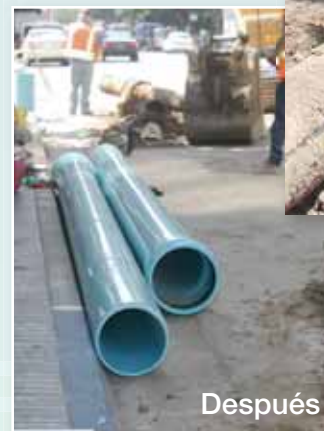
Sustituciones de acueductos de hierro fundido
