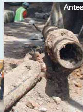
Sustituciones de acueductos de hierro fundido
