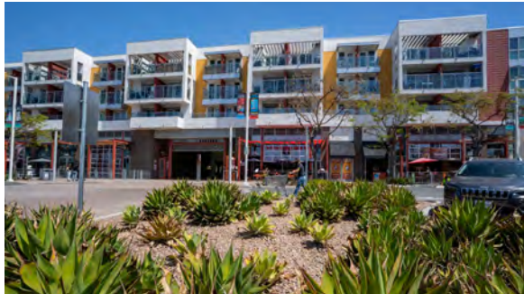
Mercado Del Barrio Apartments
