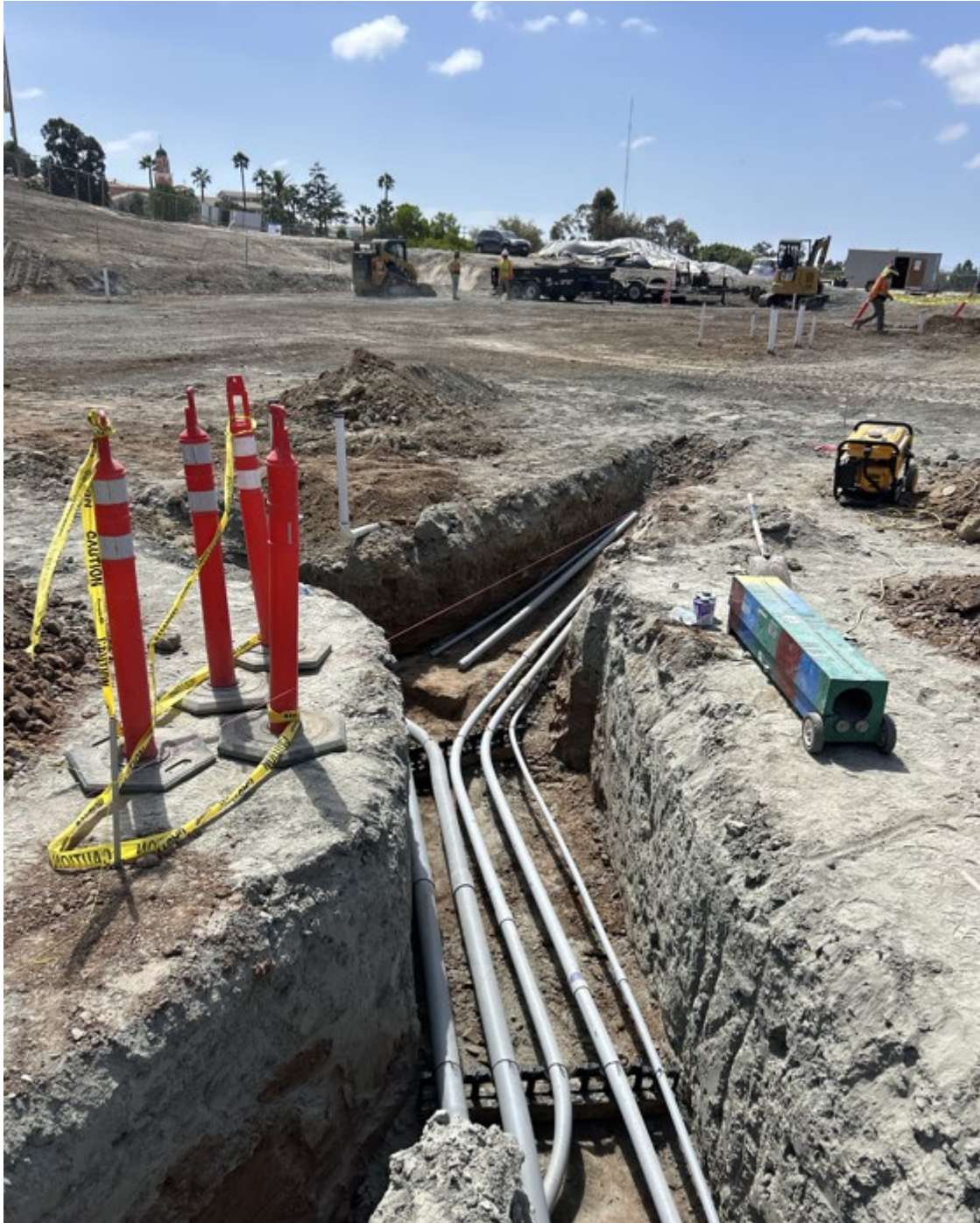
Electrical conduit installation
