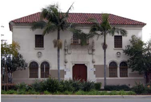
SDG&E Co., Substation F, 3169 El Cajon Boulevard.
