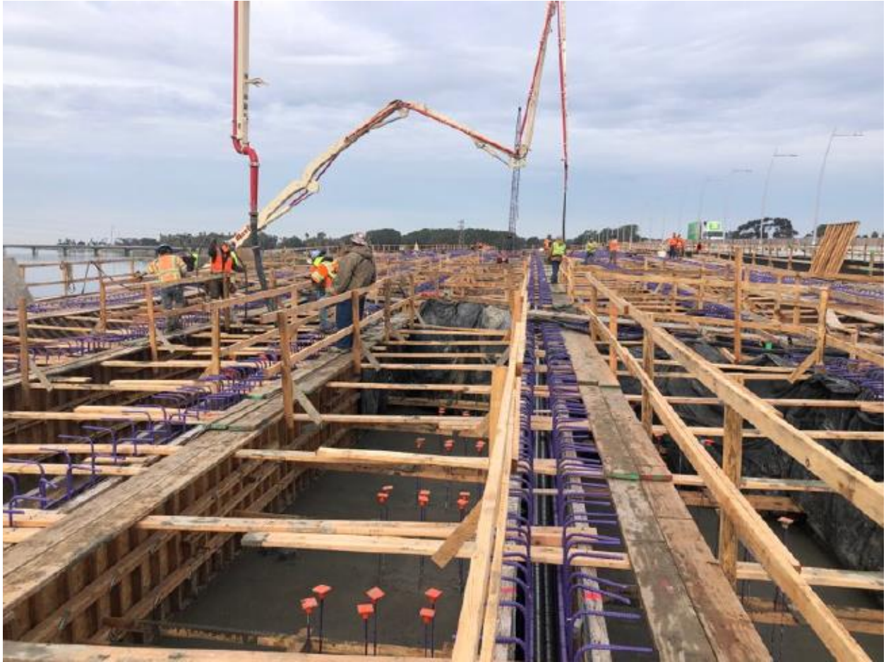
Left Bridge – Stem and Soffit Pour
