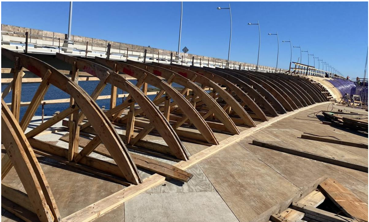
Left Bridge – Stem and Soffit Pour
