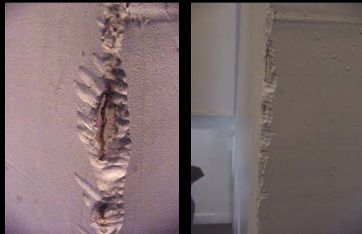
Marcas de Dientes en las Paredes
