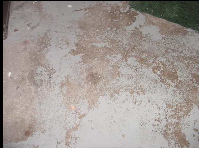
Piso de Concreto
