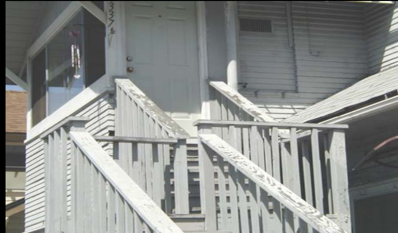
Rieles de la Escalera Deteriorados
