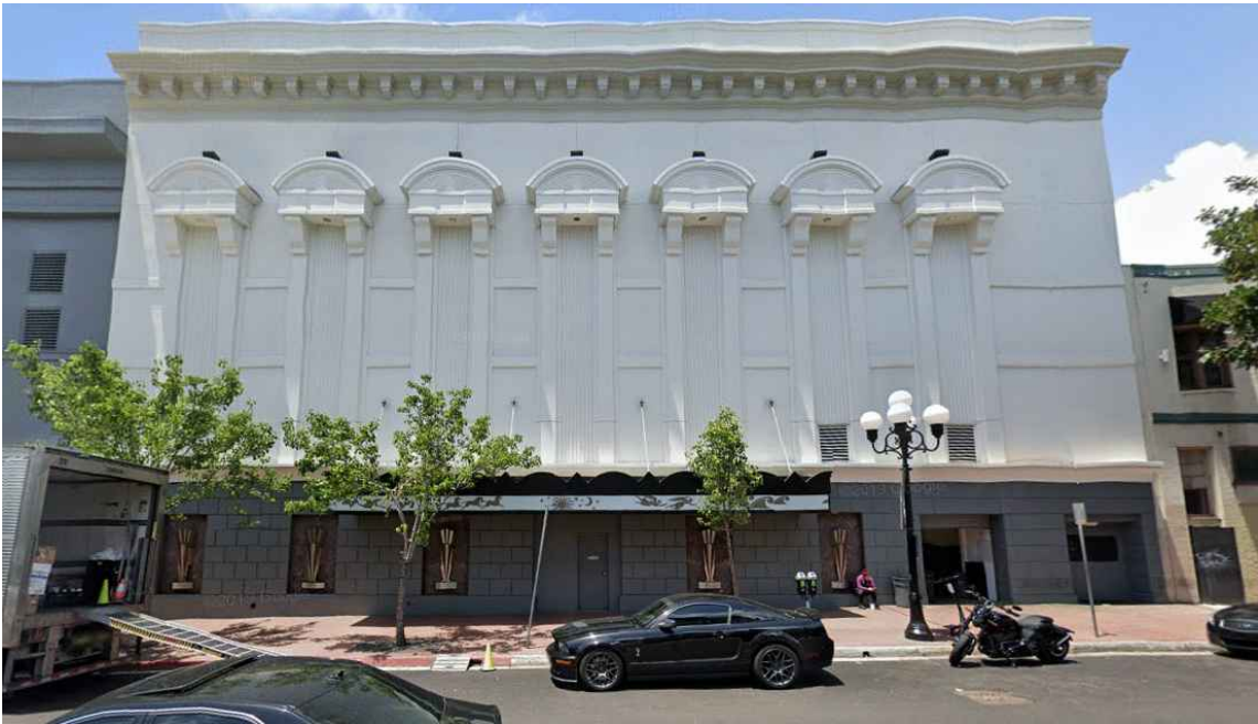
3 6TH AVE EXISTING FACADE - SCALE: N.T.S.
