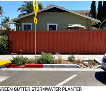
GREEN GUTTER STORMWATER PLANTER Flow Through Planter
